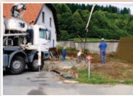
Betoniranje temeljev
