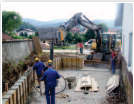
Betoniranje zidu
